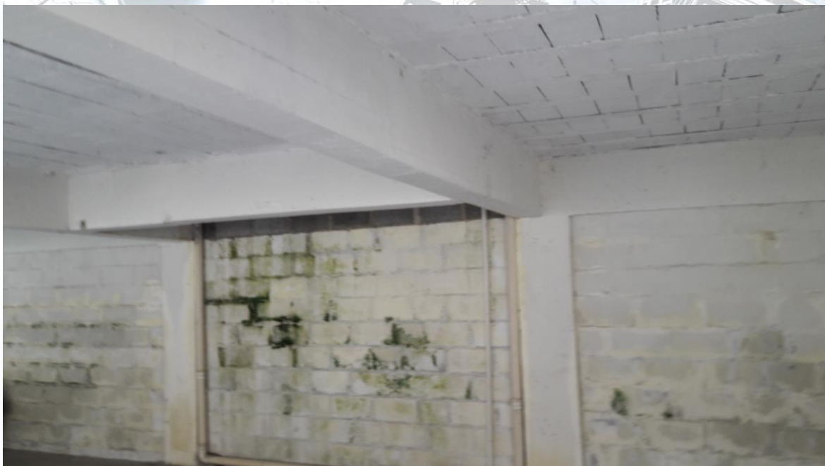
Vista das vigas e paredes ao fundo que também auxiliam no travamento da estrutura
