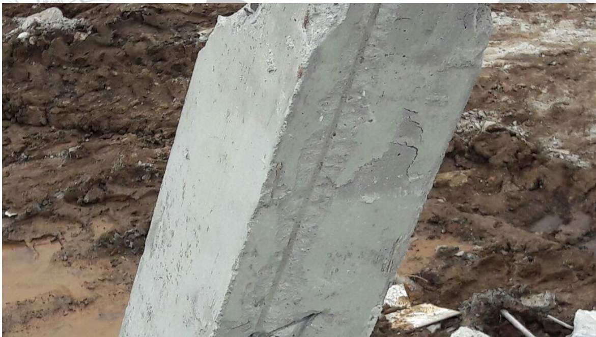
Pilar de (20x40)cm. Nos cálculos constava ferragem de 12,5mm. Foi empregado aço de 8mm.
