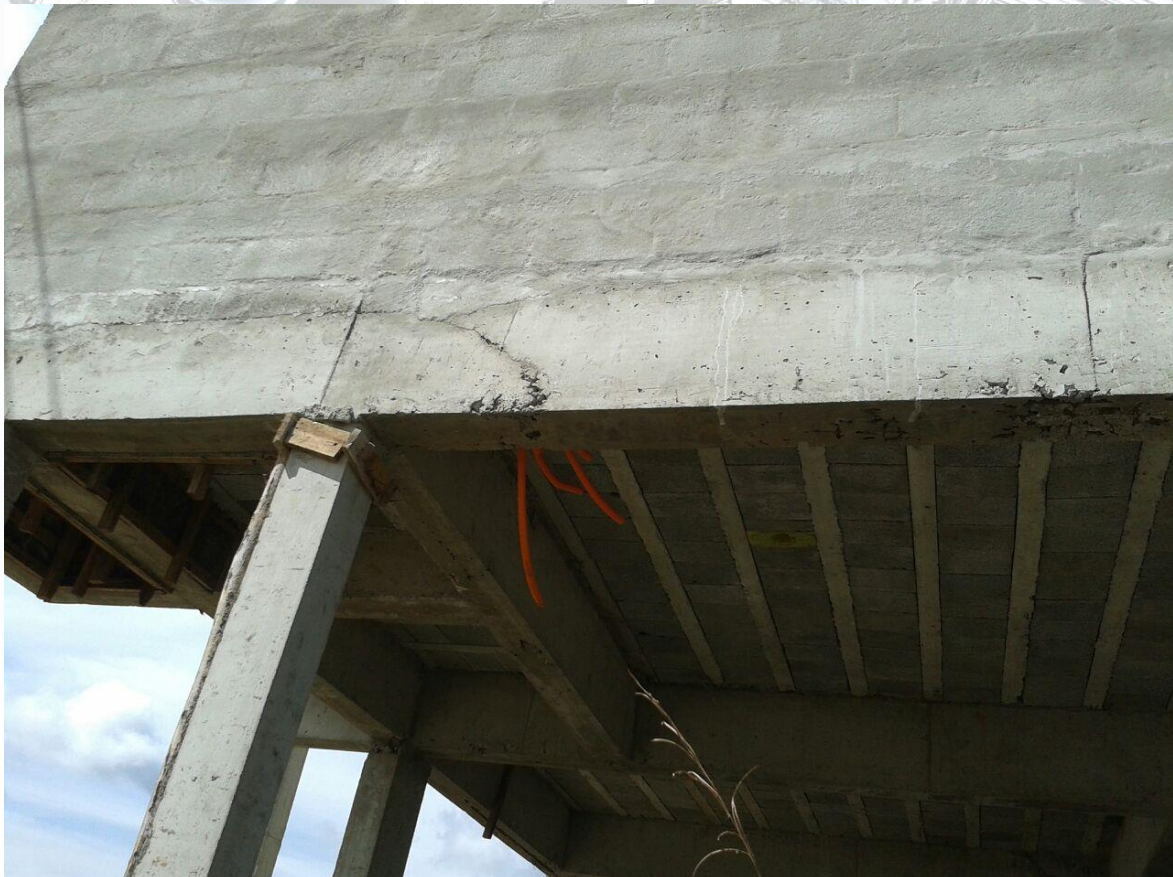
Bicheira e corrosão. A fissura é decorrente de emenda de concretagem
