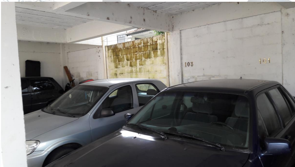
Vista da estrutura. Alvenaria que auxilia no travamento da edificação.
