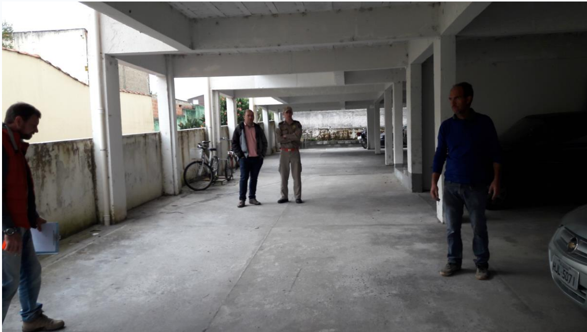
Vista da estrutura. Do lado direito, circundando a escada, alvenaria que auxilia no travamento da edificação.
