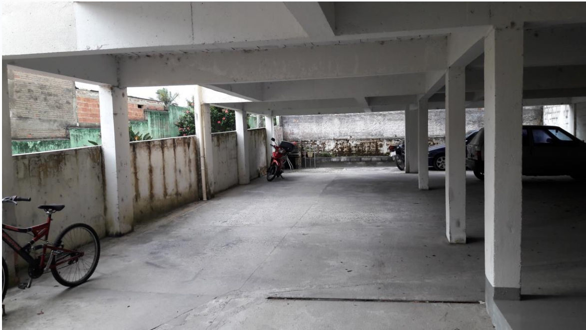
Ausência de danos significativos nas peças estruturais.
