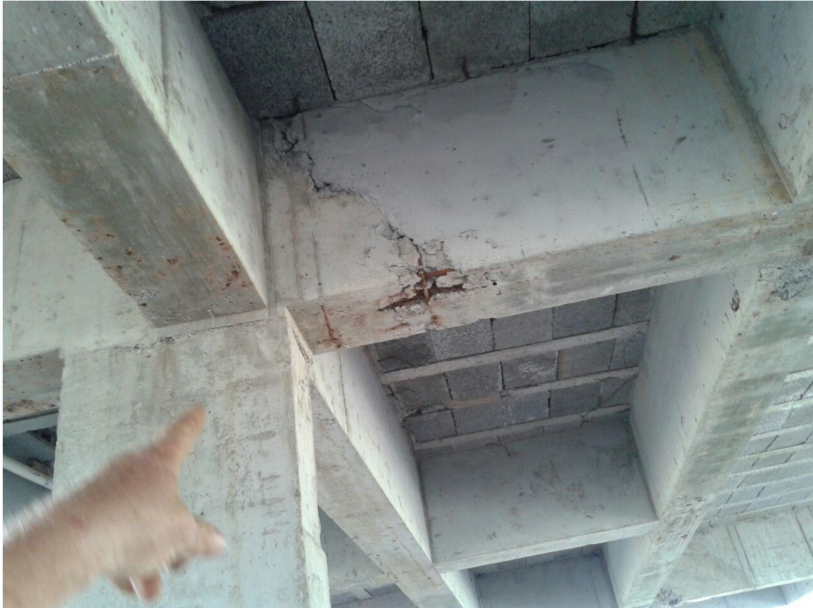
Bicheira e corrosão. A fissura é decorrente de emenda de concretagem
