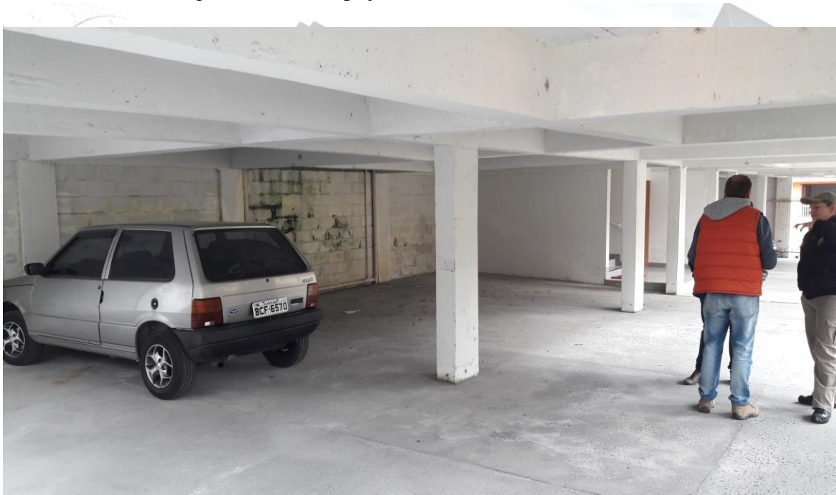
Ausência de danos significativos nas peças estruturais.
