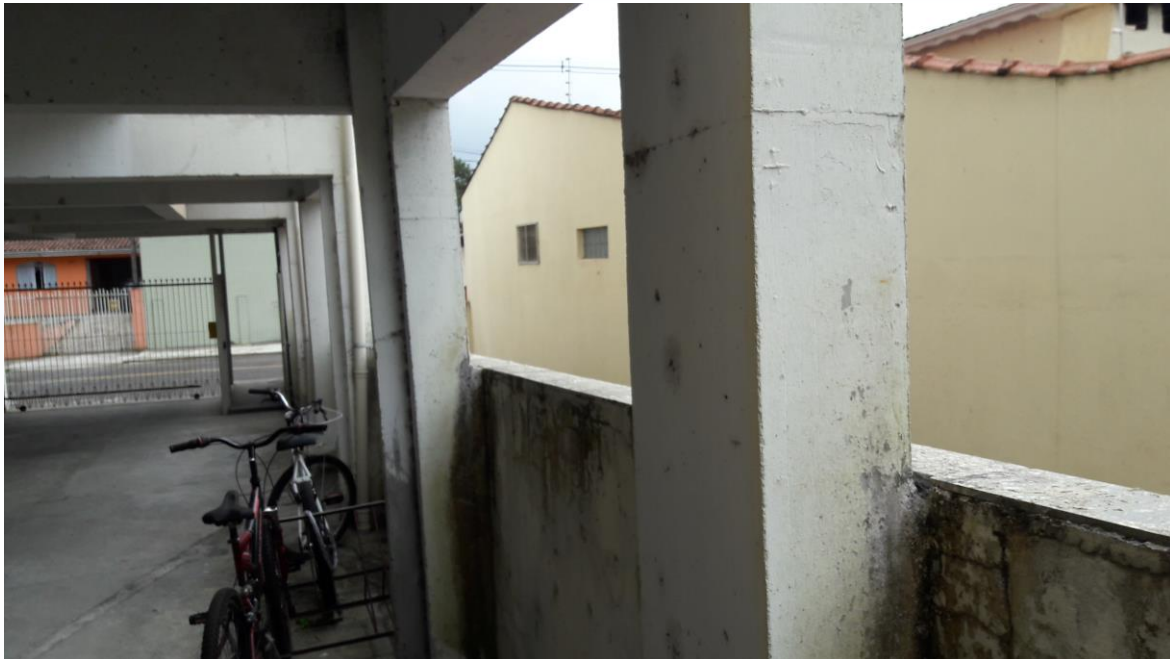
Vista dos pilares
