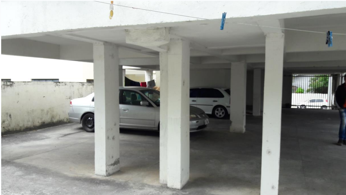
Vista da garagem (pilotis)
